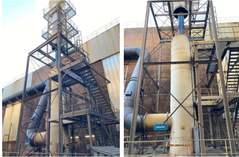
Figuur 4: Dampafzuiging Beitsbaan 12
