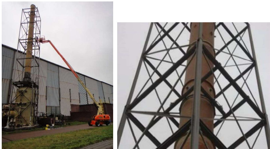
Figuur 3: Dampafzuiging Beitsbaan 21
