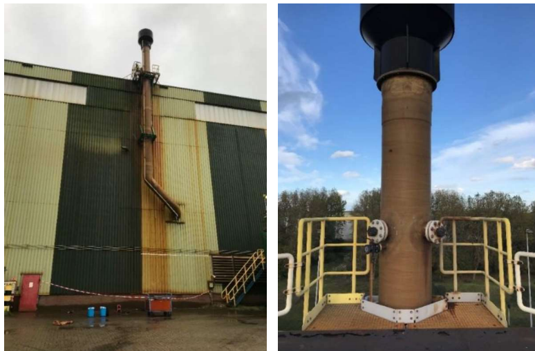
Figuur 5: Dampafzuiging Beitsbaan 22
