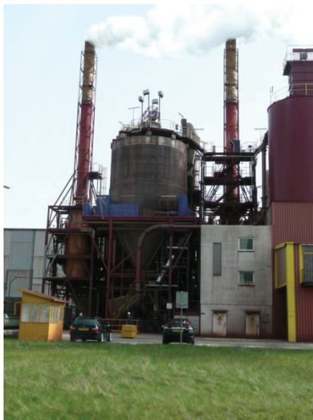
Figuur 3: Roostovens zoutzuurregeneratie Indaver
