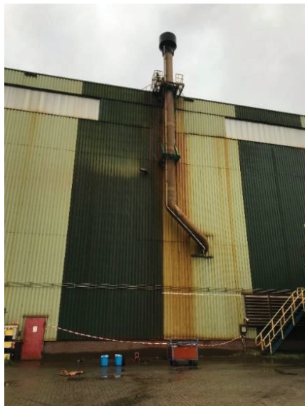
Figuur 5: Dampafzuiging Beitsbaan 22
