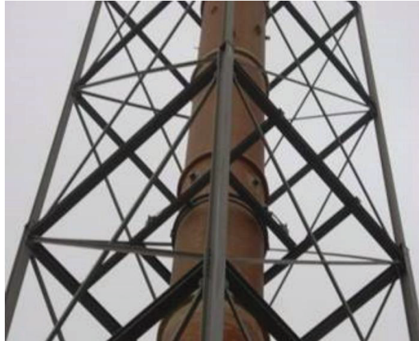
Figuur 4: Dampafzuiging Beitsbaan 21
